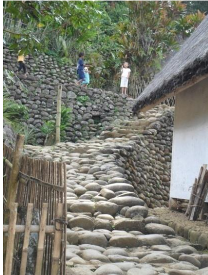
Gambar 3: Susunan batu di Kampung Naga (Dokumentasi Iwan Hermawan, 2011)
